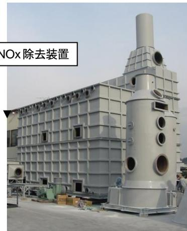
図1 還元—酸化—還元 一体型 NOx 除去装置
