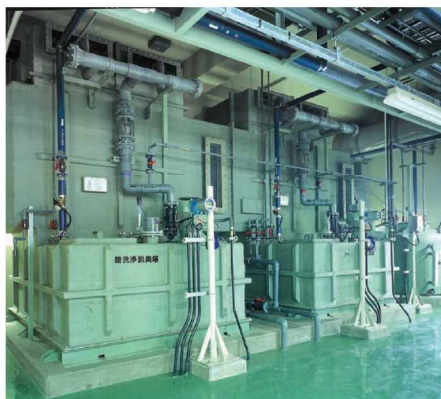
■横型薬液洗浄脱臭塔施工例
