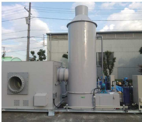
■生物脱臭塔施工例
