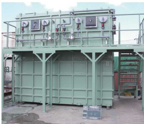
■生物脱臭塔施工例
