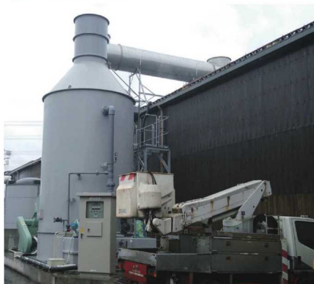
■横型薬液洗浄脱臭塔施工例
