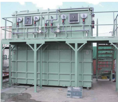
■生物脱臭塔施工例
