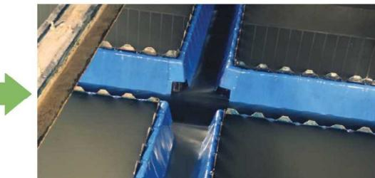
上の写真は沈殿池の越流水流出部に、整流板設置前と設置後における処理水の整流状況を比較したものです。整流板設置後の方が処理水の流れがスムーズになり、発泡量が大幅に減少していることがわかります。
