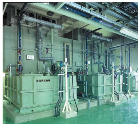
■横型薬液洗浄脱臭塔施工例
