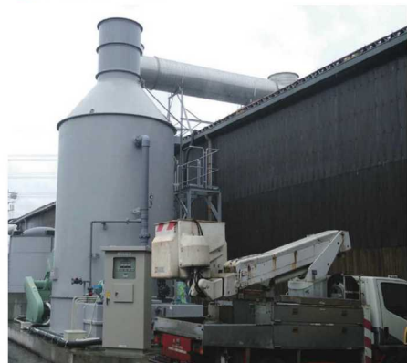
■横型薬液洗浄脱臭塔施工例
