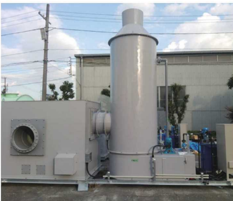
■生物脱臭塔施工例
