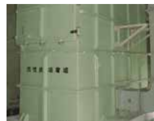
AC 形 ( 活性炭吸着塔 )
