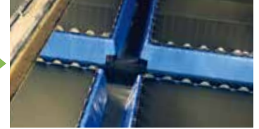
整流板設置後
