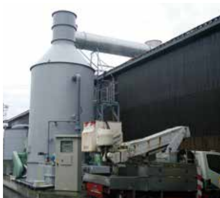
■横型薬液洗浄脱臭塔施工例
