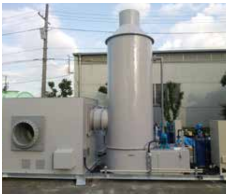
■生物脱臭塔施工例
