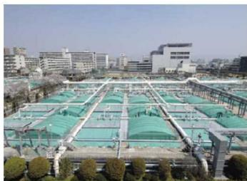
各槽の大きさ、メンテナンスを考慮した長方形池用カバーです。着色・形状も自由に選定できます。梁なし屋根(自立形)を作り上げ、雄大で繊細な曲線美を浮かび上がらせます。
