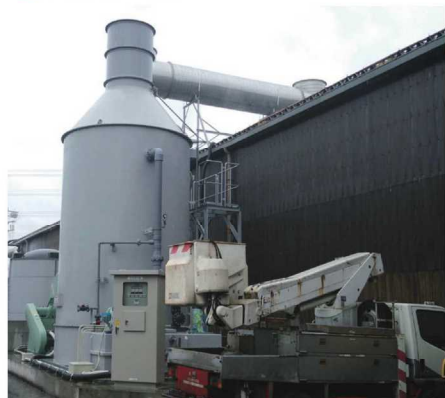
■横型薬液洗浄脱臭塔施工例
