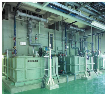
■横型薬液洗浄脱臭塔施工例
