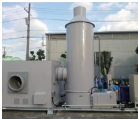
■生物脱臭塔施工例
