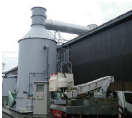
■横型薬液洗浄脱臭塔施工例
