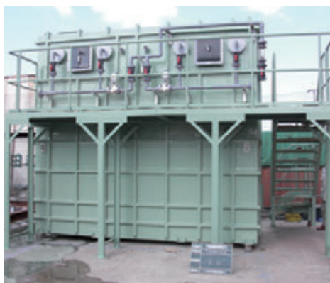
■生物脱臭塔施工例
