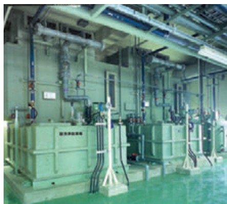
■横型薬液洗浄脱臭塔施工例
